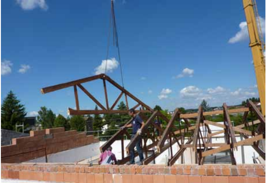
Abbau der Nagelbinder des alten Sportheims
