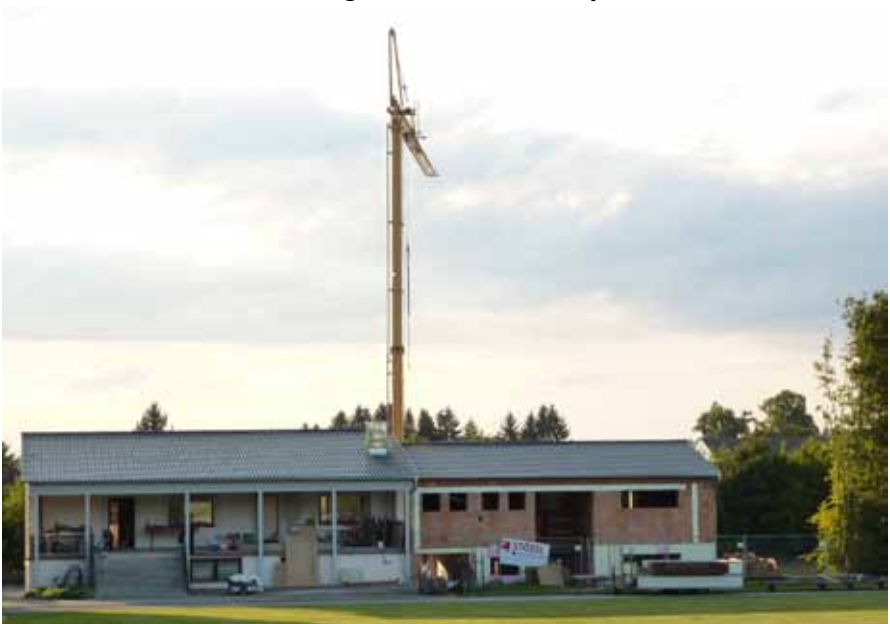
Sportheim und Anbau mit fertig eingedecktem Dach
